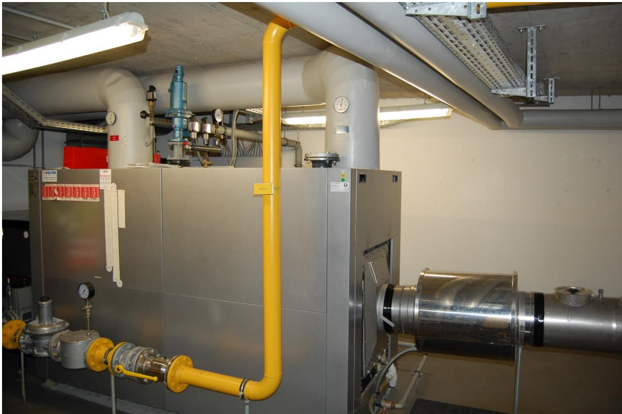
Abbildung 16: Ein Gas-Heizkessel mit mehreren hundert kW Leistung in einem Shopping-Center
