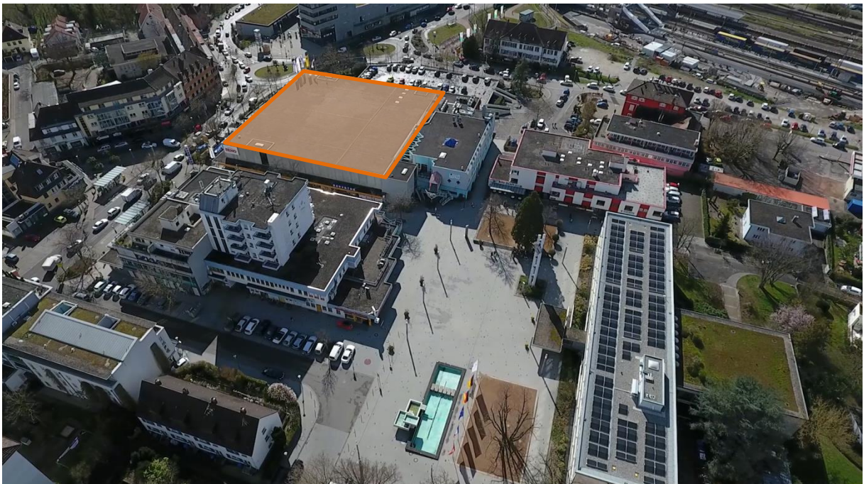
Abbildung 75: Objekt Kaufring Ostseite, Quelle: Drohnenaufnahme
