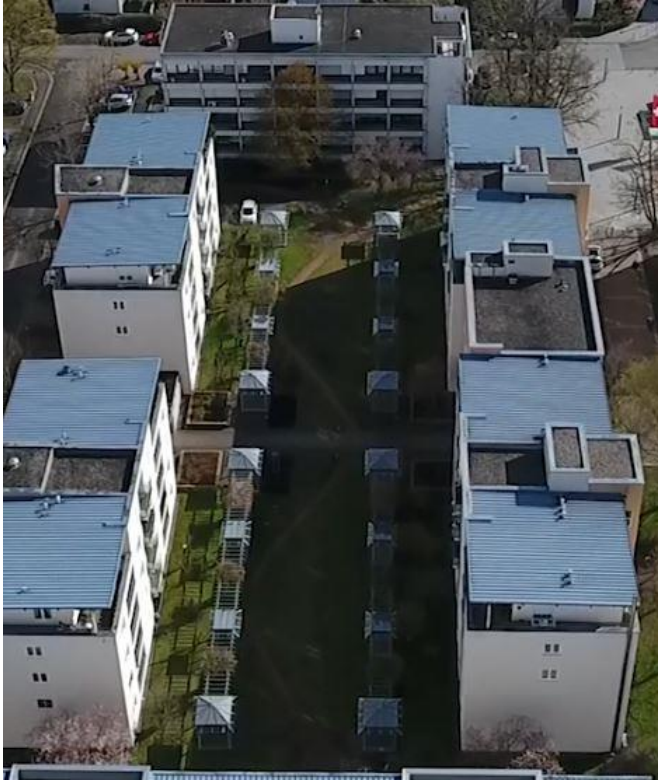
Abbildung 44: Schattenspendende Pavillons Lessingstraße (Drohnenflug endura kommunal 2018)
