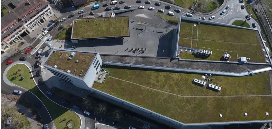
Abbildung 42: Dachbegrünung auf der Einkaufsinsel für Regenwasserrückhaltung und Temperierung (Drohnenflug endura kommunal 2018)
