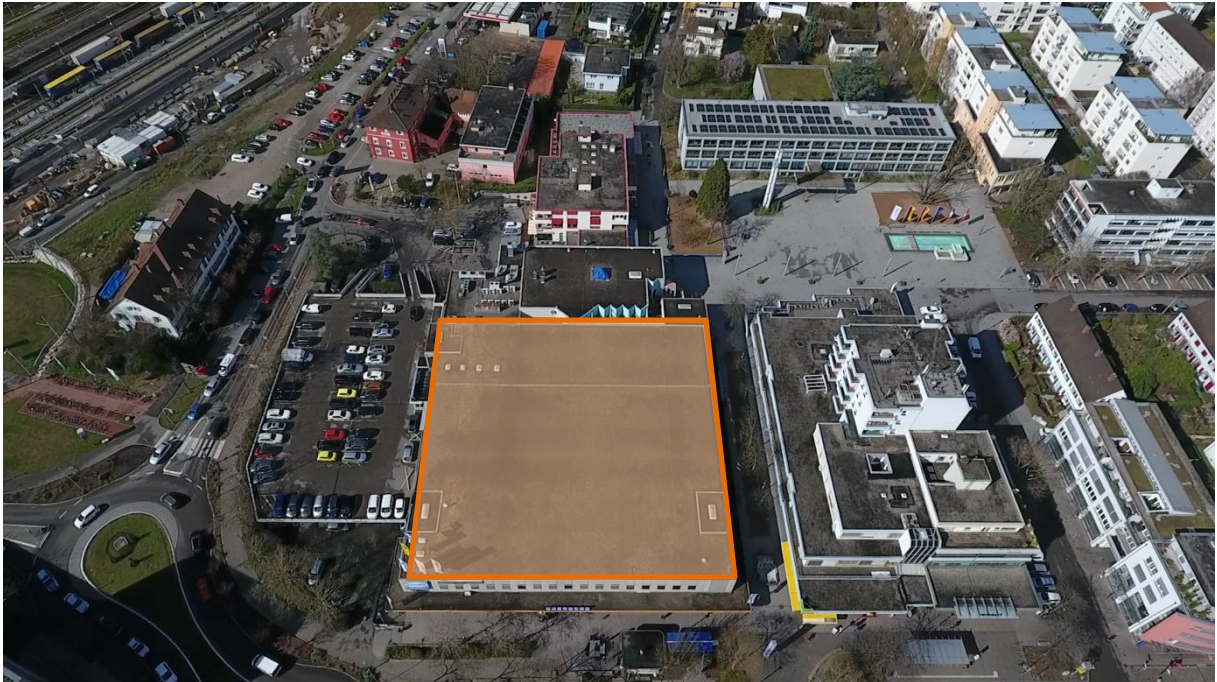
Abbildung 74: Objekt Kaufring Südseite, Quelle: Drohnenaufnahme
