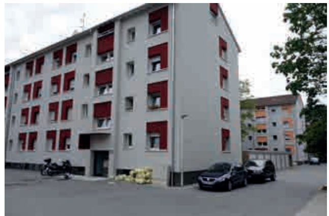
Abb. 21: Wohngebäude im Eigentum von Wohnungsunternehmen
