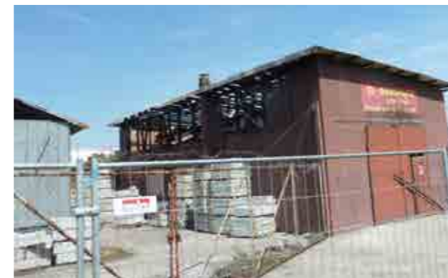
Abb. 28: Lagerhalle im Hafengebiet
